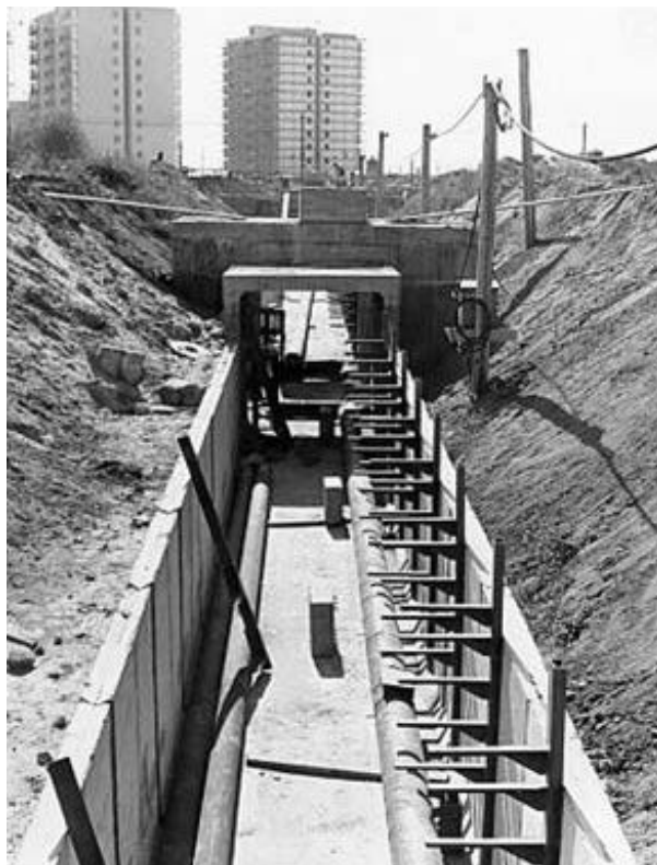
14. fotó: A pesterzsébeti közműalagút építése
