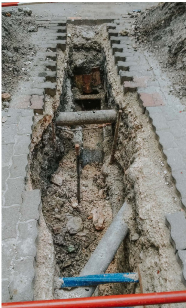
25. fotó: Gázvezeték rekonstrukció, Visegrádi utca, Budapest
