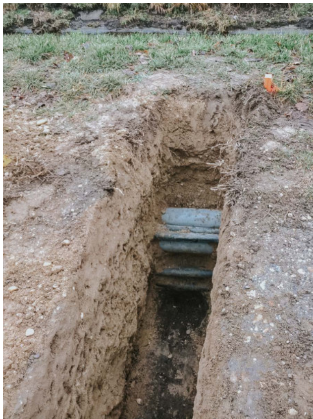
29. fotó: Közműfeltárás, távközlési kábelek a Rákospatak mentén, Budapest
