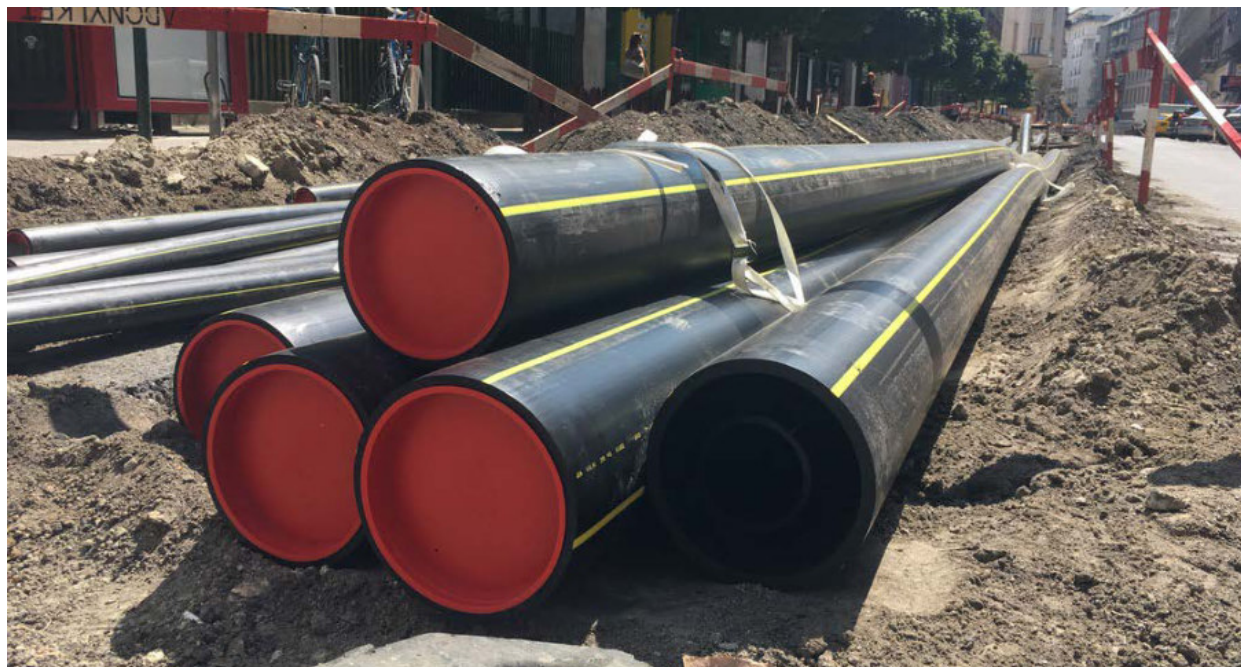
18. fotó: Gázvezeték rekonstrukció
