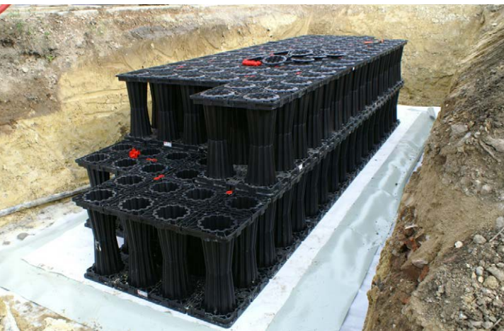
48. fotó: Szikkasztóládás csapadékvíz szikkasztás
