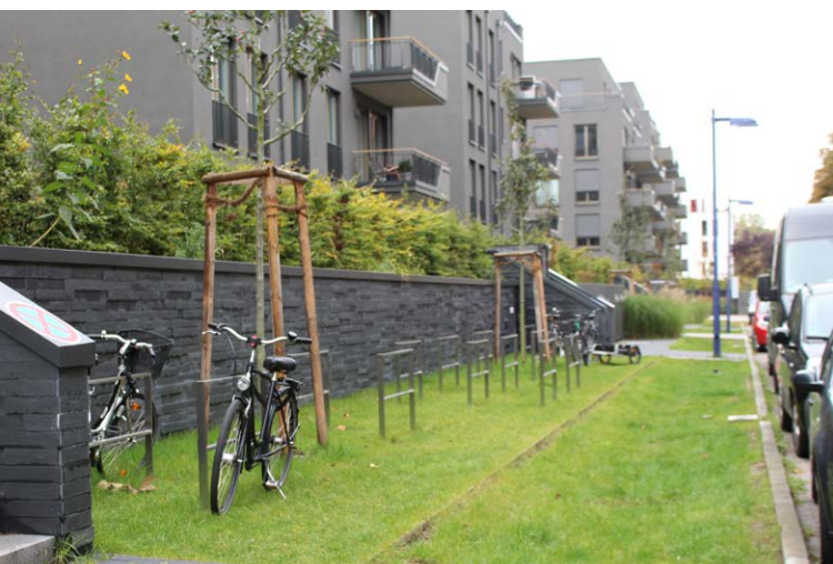
70. fotó: Gyepes kerékpártárolók és szikkasztóárkok
