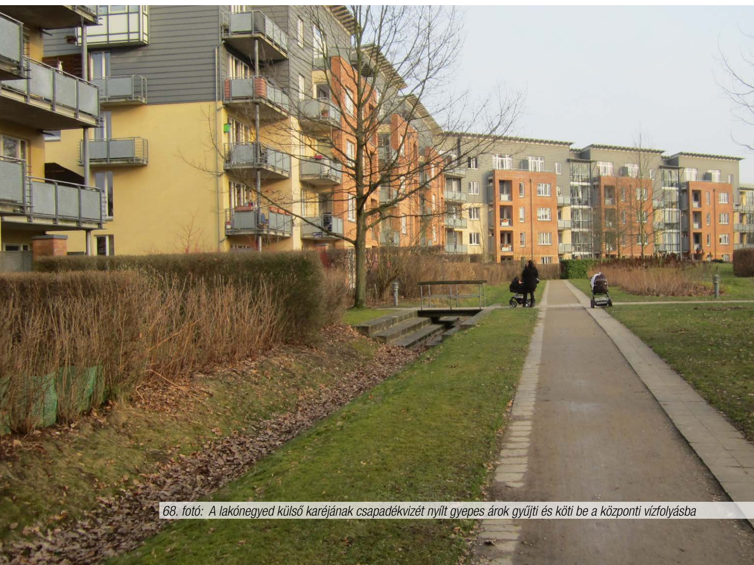
67. fotó: Az épületek közötti gyalogos sétány és a csapadékvizet összegyűjtő mesterséges vízfolyás
