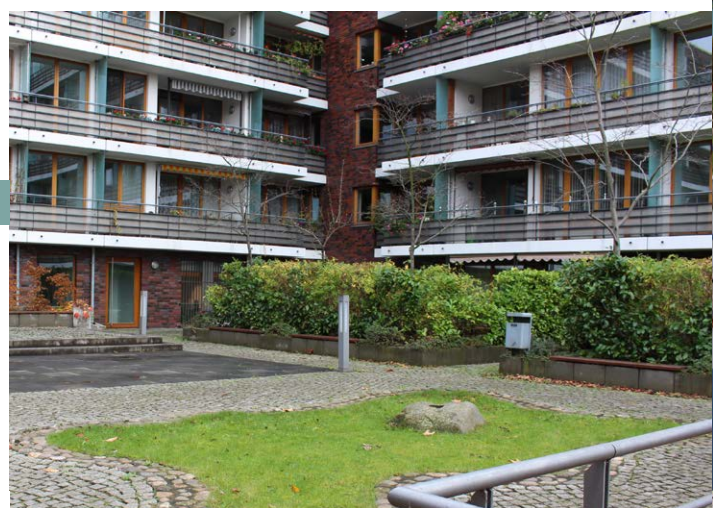
71. fotó: Vízteresztő burkolatok és szikkasztó zöldfelület
