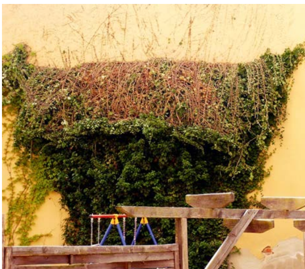
231. ábra Többletterhelés miatt a falról leszakadt a borostyán ( Hedera helix )
