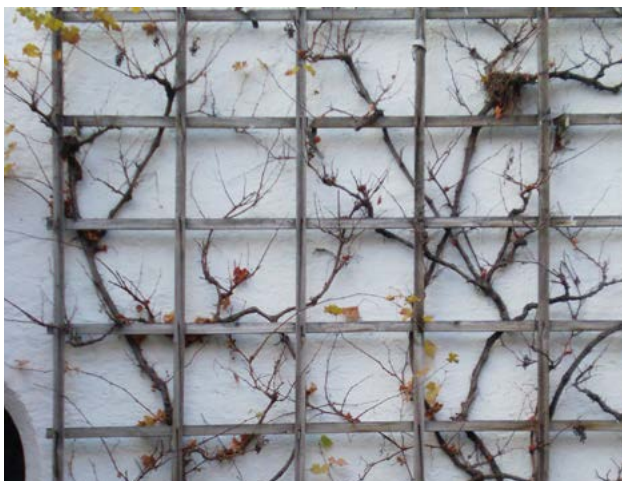
165–166. ábra Felületjellegű farács támszerkezet kaccsal rögzülő szőlő ( Vitis sp. ), illetve függesztett acélsodrony háló csavarodó növény esetén
