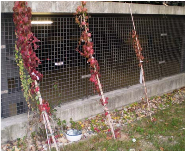
209. ábra Kúszónövények tövének védelmére, megtámasztására a megeredési időszakban is szükség lehet (Stuttgart, parkolóház)
