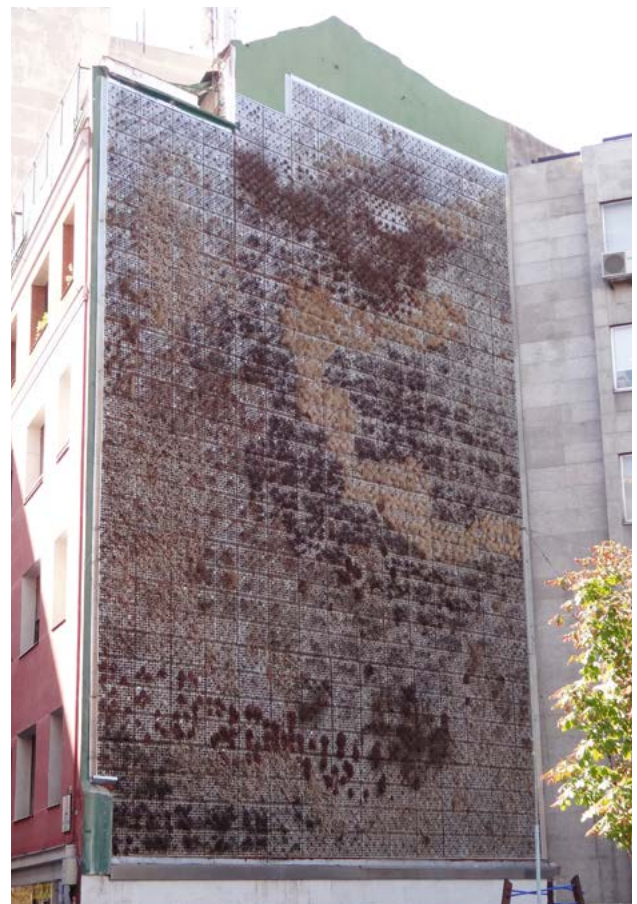
224–226. ábra Üzemeltetés hiánya a zöldfal visszafordíthatatlan tönkremenetelét okozhatja
