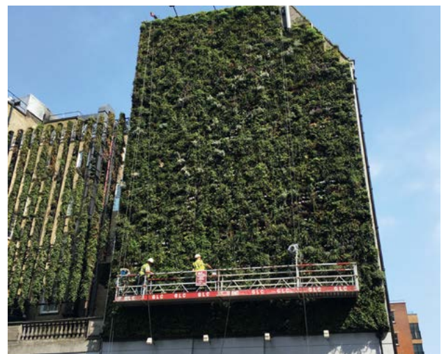
210–213. ábra Zöldhomlokzat karbantartása létrás, emelőkosaras, alpinetchnikus és függesztett hidas megközelítéssel (két bécsi, budapesti és londoni épület esetén)
