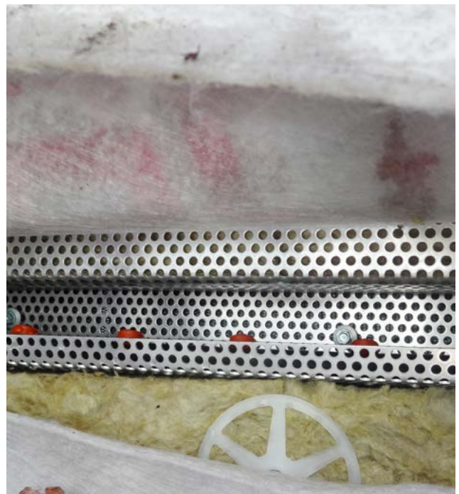
181–183. ábra Különböző ültetőközegek: szervetlen örléménnyel feltöltött kazetta, zöldfalban alkalmazható filc (technikai textília) és kőzetgyapot egy filces rendszerben
