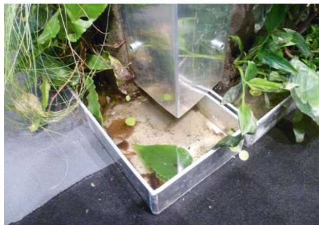
220–221. ábra A drénvíz elvezetése a talajtól független rendszerek esetén az épület lábuzatánál folyókával
