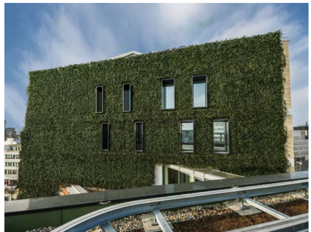
76–77. ábra Előnevelt panelek alkalmazása parkolóház (Rotterdam) és középület (HaseHaus, Osnabrück) homlokzatán
