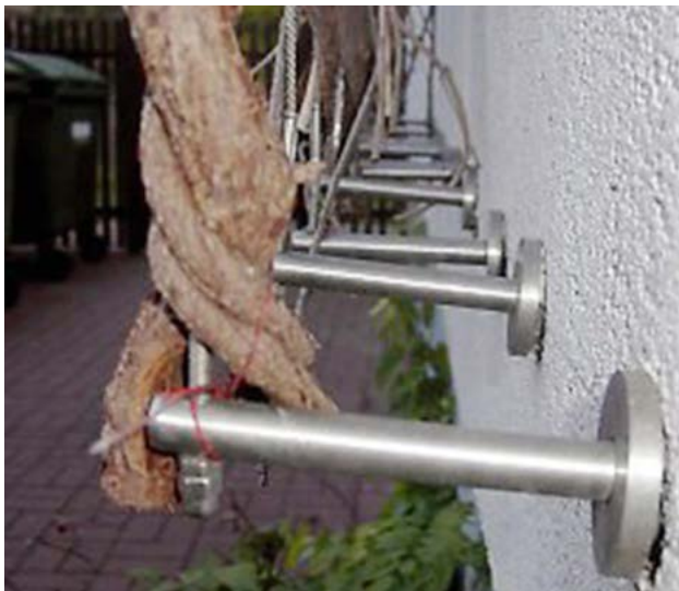
229–230. ábra Lilaakác ( Wisteria sp. ) erősen csavarodó hajtásai a támszerkezet rögzítéseit kimozgatták, illetve az erős hajtás benőtte az alumíniumozott támszerkezetet
