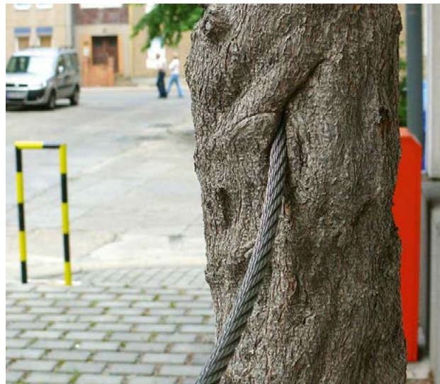
229–230. ábra Lilaakác ( Wisteria sp. ) erősen csavarodó hajtásai a támszerkezet rögzítéseit kimozgatták, illetve az erős hajtás benőtte az alumíniumozott támszerkezetet
