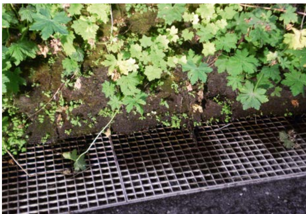
220–221. ábra A drénvíz elvezetése a talajtól független rendszerek esetén az épület lábuzatánál folyókával
