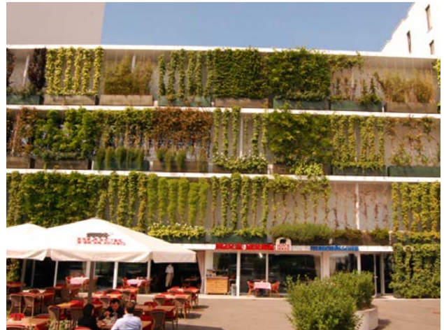
71. ábra Konzolos lemezre helyezett planténerből vonalas jellegű támszerkezetre futtatott növények (Shopping Center Stückfärberei, Basel)
