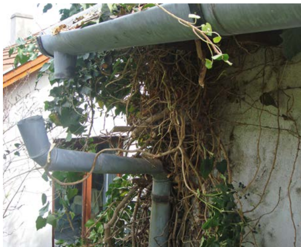
203–204. ábra A homlokzatfelületről túlnyúló hajtások eltömíthetik az ereszcatornát, leszakíthatják az ejtőcsövet, ereszcatornát
